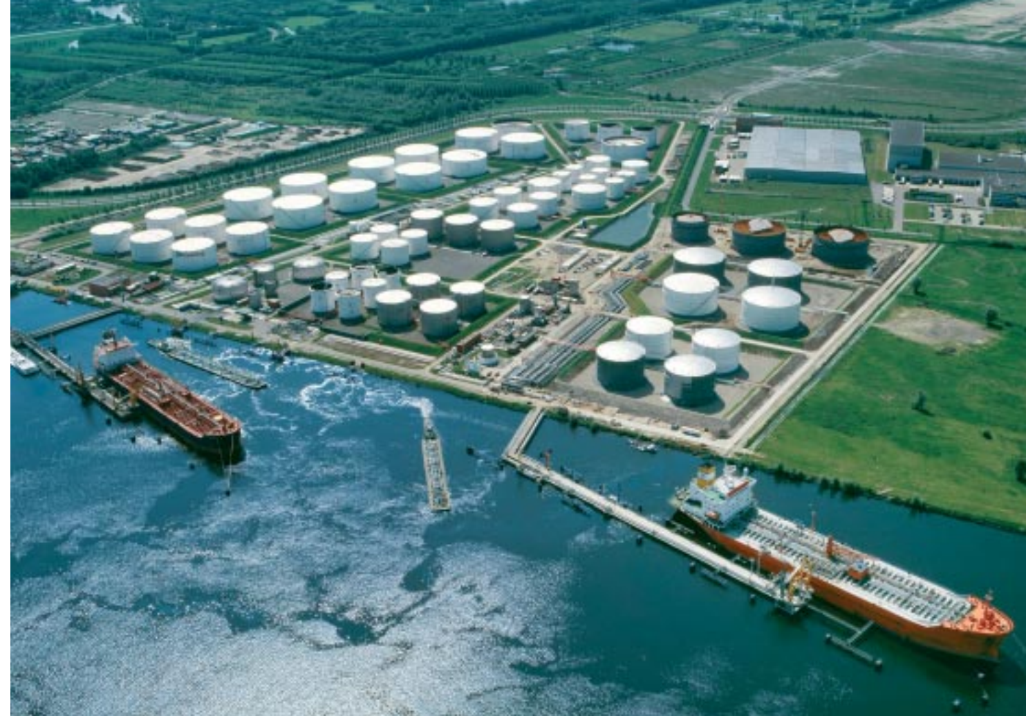
El terminal de Oiltanking Amsterdam: Con los nuevos tanques, la capacidad de tanques creció en un 34%. Los nuevos muelles incrementaron su capacidad en un 40%.
