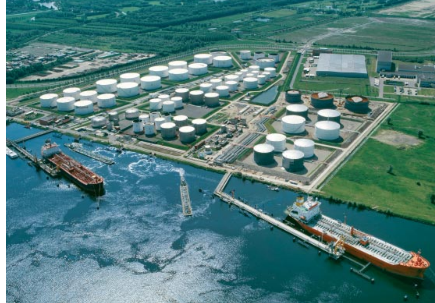
Das Oiltanking Tanklager in Amsterdam: Mit den neuen Tanks erhöhte sich die Kapazität um 34%. Die neuen Anlegestellen erhöhten ihre Kapazität um 40%.
