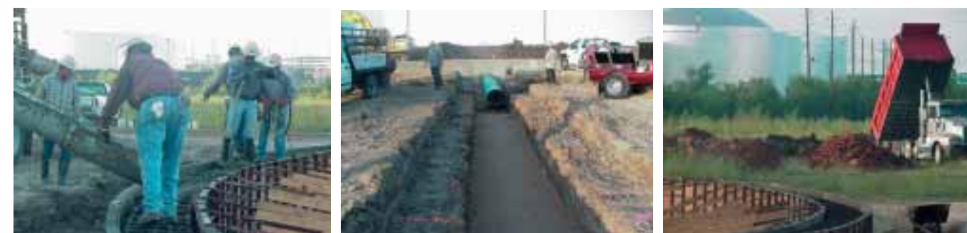
Cómo construir un nuevo tanque: Vaciado y vibrando casi simultáneamente.
