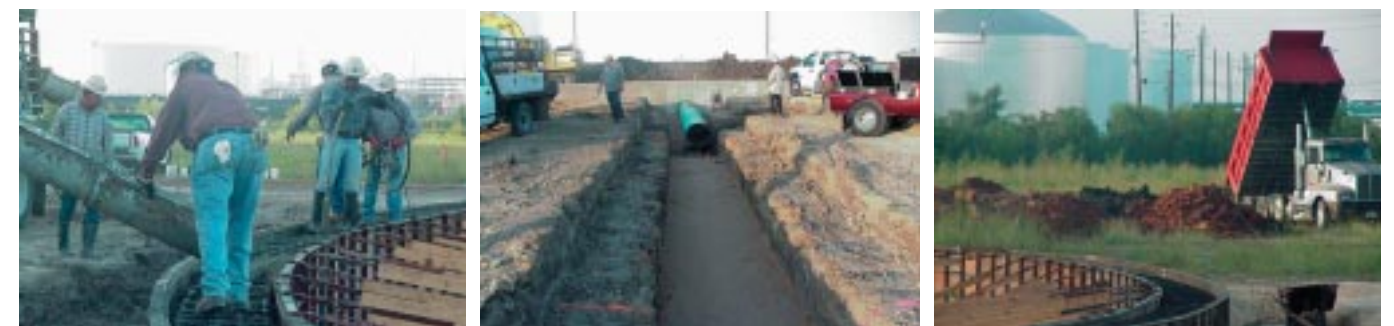
Bau eines neuen Tanks: Gleichzeitiges Schütten und Vibrieren von Beton.
