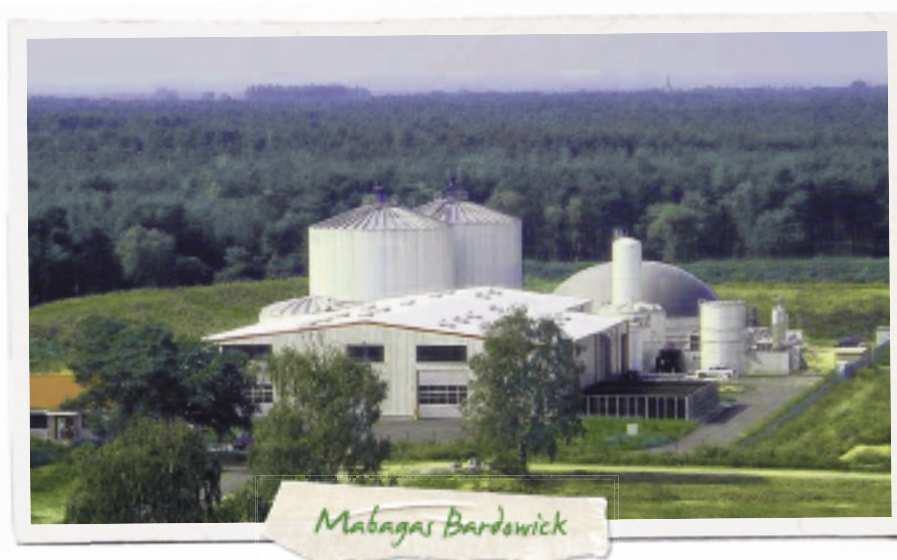
Mabagas übernahm 2012 eine bestehende Biogasanlage in Bardowick bei Lüneburg.
